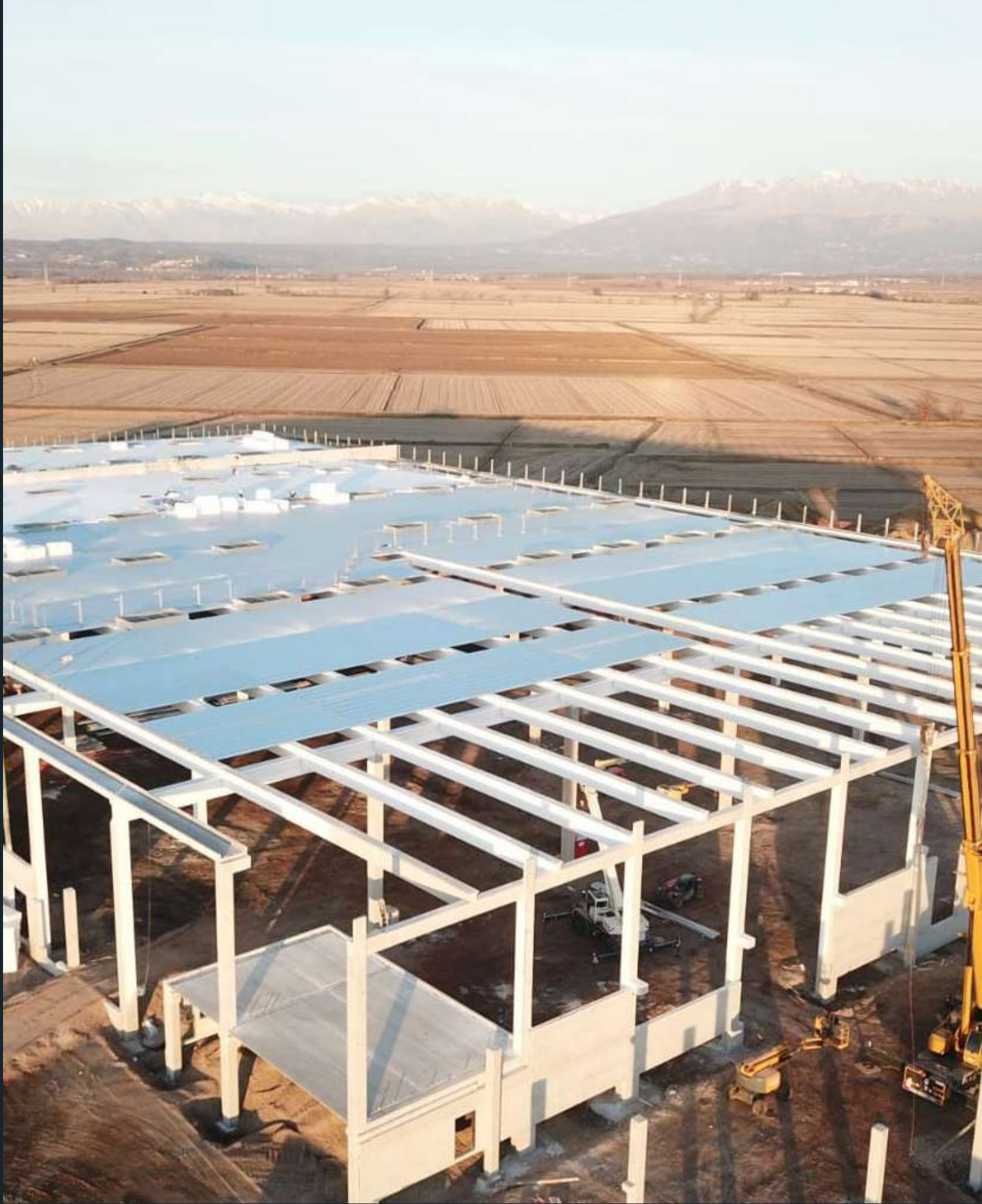
rif. Carisio (VC) Copertura e facciata polo logistico
